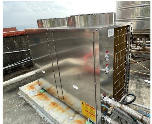
武嶺一村熱泵主機汰換
