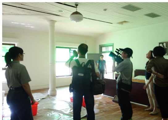
大愛電視採訪蔣公行館受損 拍攝屋頂漏水
